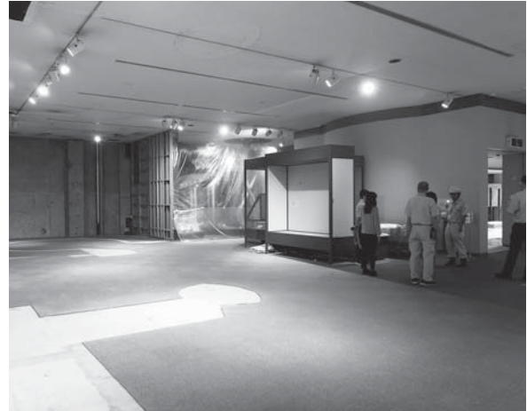
旧常設展示室 解体工事終了直後の状況
