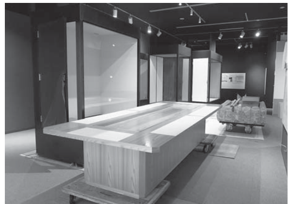
工事中の歴史展示室(旧常設展示室)
