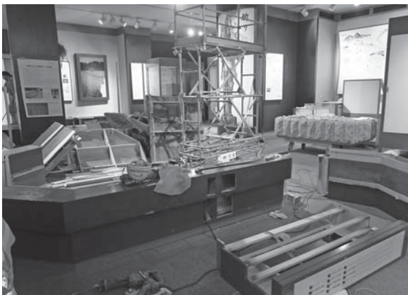
解体工事中の旧常設展示室
