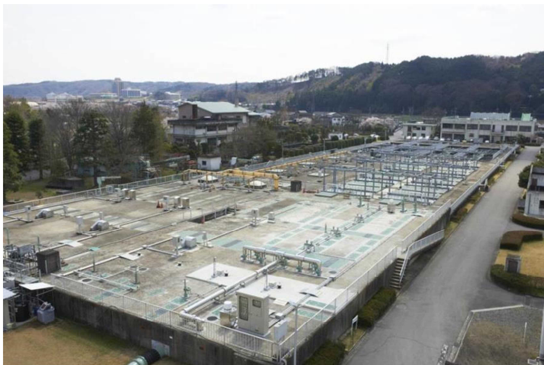
飯能市浄化センター
