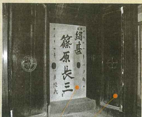
引き戸 観音扉 一階奥観音扉
