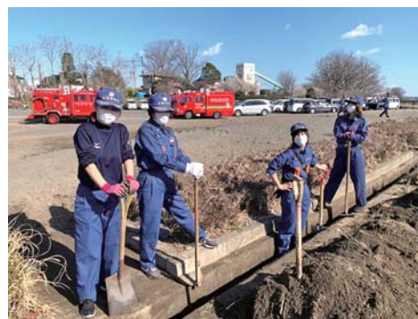
岩沢運動公園土砂撤去作業
