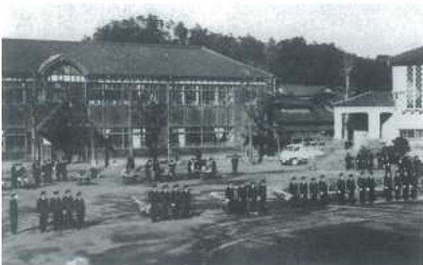
昭和30年代の消防点検（第一小学校）
